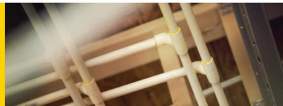
**FLOWGUARD GOLD® SE UNE MEDIANTE UN PROCESO DE SOLDADURA RÁPIDO Y FÁCIL UTILIZANDO CEMENTO SOLVENTE DE UN SOLO PASO.**
